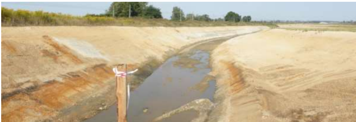
Fot 3. Wykop przełożonego koryta rzeki Psiny
