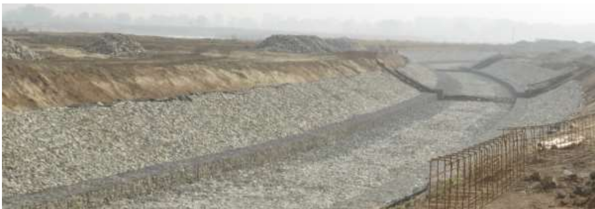
Fot 4. Wykop i umocnienie koszami siatkowo-kamiennymi koryta rzeki Psiny na terenie czaszy zbiornika.
