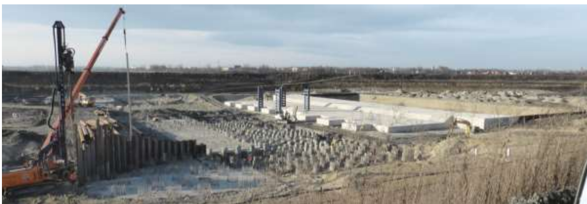
Fot 2. Wykonane wzmocnienie podłoża pod budowlę przelewowo-spustową, oraz część niecki wypadowej. Z lewej strony zdjęcia – zabijanie ścianki szczelnej od wody górnej.
