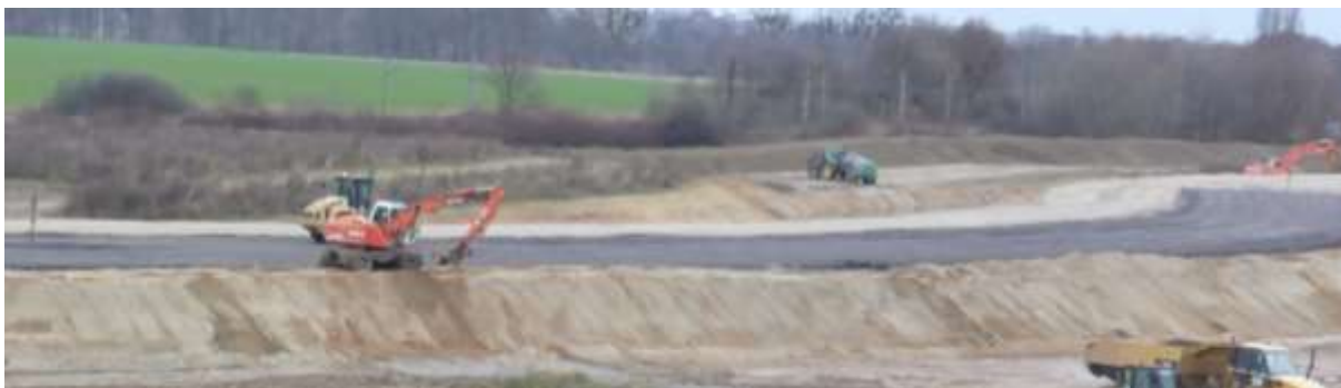
Fot 5. Budowa korpusu zapory lewobrzeżnej.
